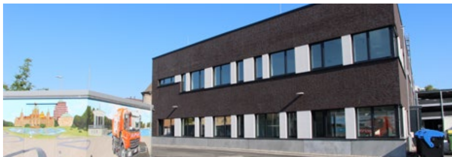
Sozialgebäude in Passivhausbauweise Gertrud-Knebusch-Straße
