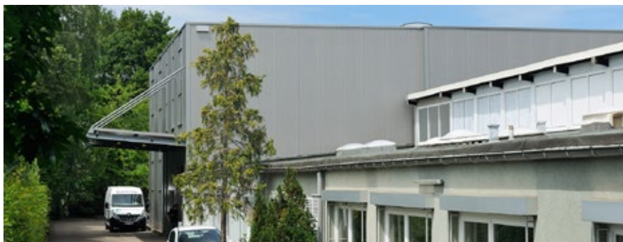
Büro und Lagerhalle
