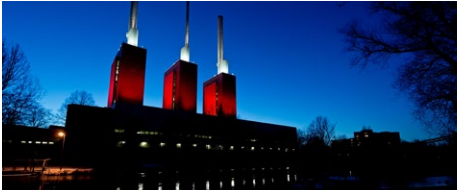
beleuchtetes Heizkraftwerk Linden bei Nacht
