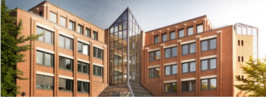
Hauptgebäude der Hannover Rück
