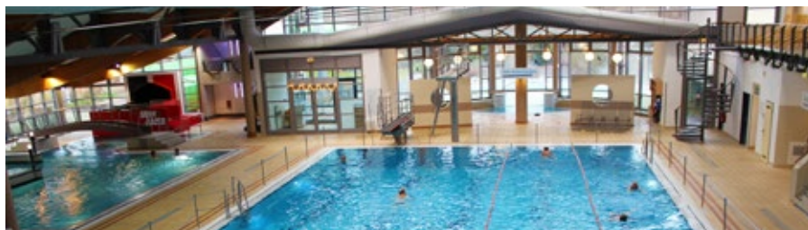
Tageslichtabhängige Beleuchtung in den Schwimmhallen
